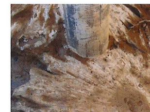
補強体掘削状況 (杭との接合部)
