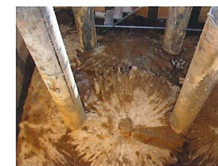
補強体掘削状況
