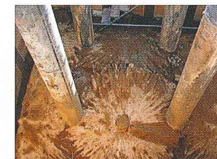
補強体掘削状況
